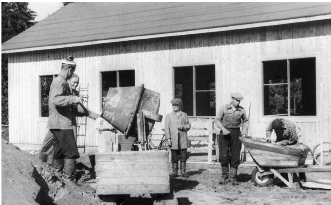
Valu käynnissä Könönpellon Metallin ensimmäisen pajan työmaalla vuonna 1950. Betonimyllyllä Esko Asikainen ja Matti Salakka. Kottikärryllä Valpas Asikainen vierellään Vihtori Koponen ja Eino Lipponen.
